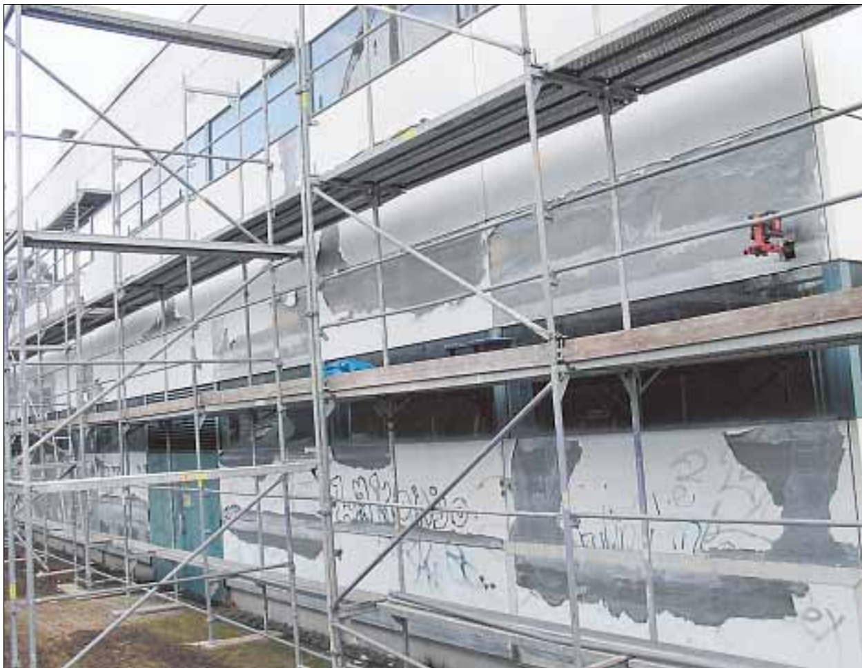
Das Gerüst steht schon: Die Sanierung der Fassade der Sporthalle am Deutenberg beginnt.
