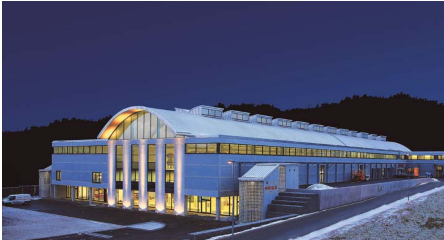
Durch viele Oberlichter im imposanten Gewölbendach des neuen MEGA-Fachzentrums für Metzger und Gastronomen in Stockach hat Architekt Wolfgang Scheible eine lichtdurchflutete Markthalle für die Kunden des Cash- und Carry-Marktes geschaffen. BILD: MEGA
