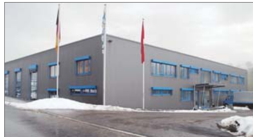
Der Neubau der Firma Jowos Metalltechnik GmbH & Co. KG in Seitingen-Oberflacht. Fotos: Ingrid Kohler
