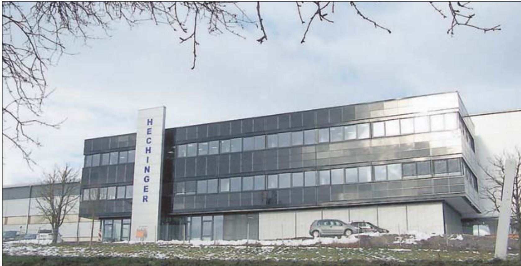
Der im ersten Bauabschnitt fertiggestellte Verwaltungstrakt der Helmut Hechinger GmbH + Co. KG in der Schwenninger Junkersstraße 4.
