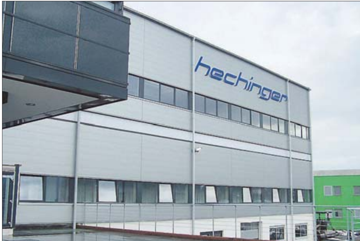
In einem zweiten Bauabschnitt entstand jetzt der silbern glänzende Trakt für die neuen Produktionsflächen. Insgesamt beherbergt der Neubau auf drei Etagen 5500 Quadratmeter. Fotos: Sabine Krümmner
