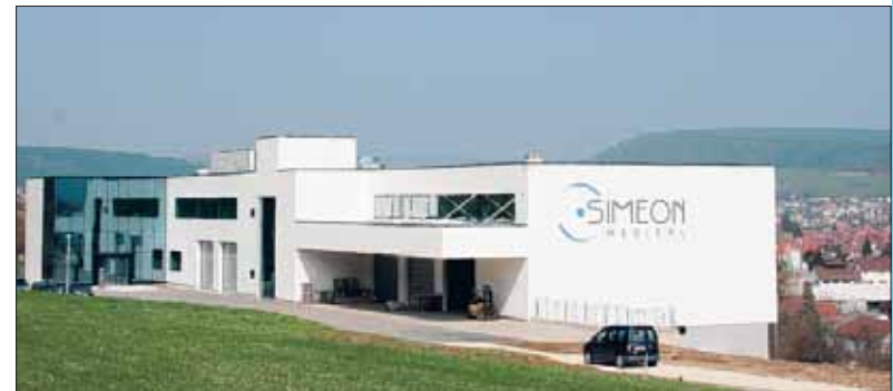
In exponierter Lage im Gewerbegebiet „Grubenäcker“ hoch über Tuttingen hat Simeon Medical seinen neuen Firmensitz.
