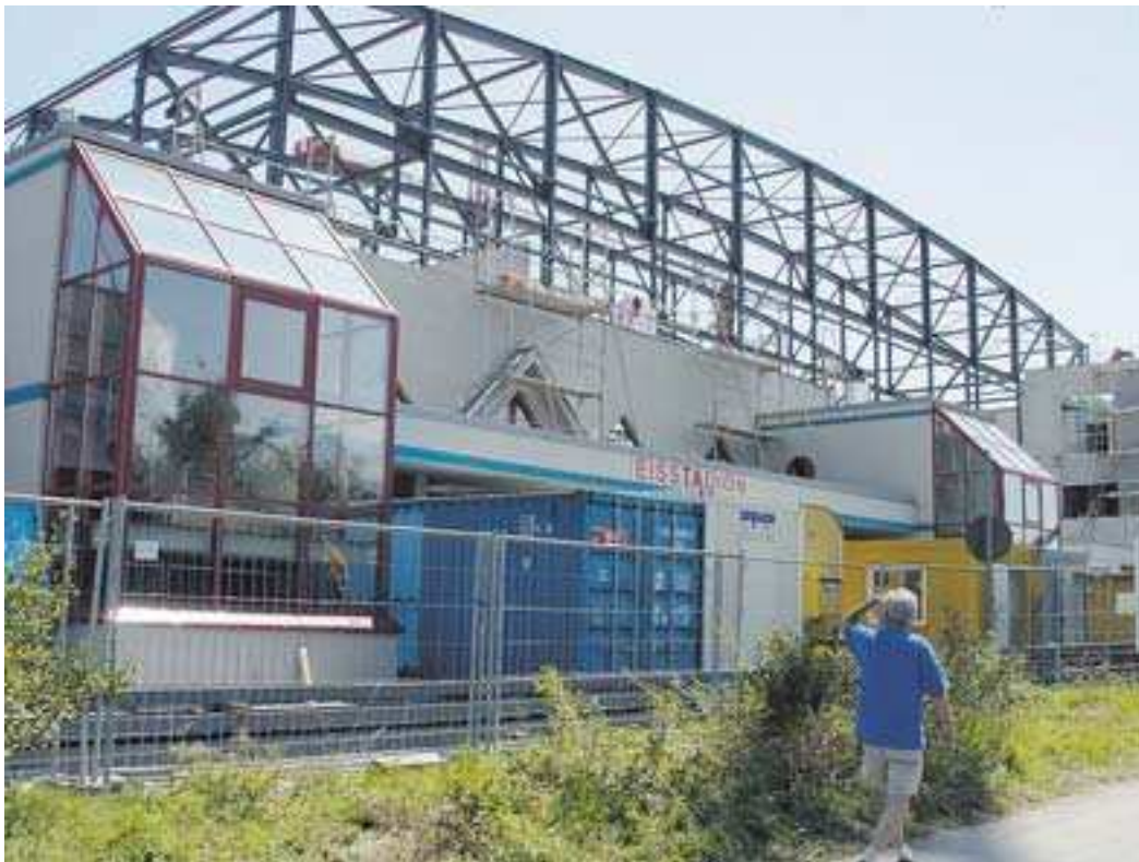
Mit Spezialkränen wurde im Sommer die Stahlkonstruktion des neuen Daches, das der Helios-Arena einen ganz besonderen Charakter gibt, auf ihre massiven Betonträger gehievt.
