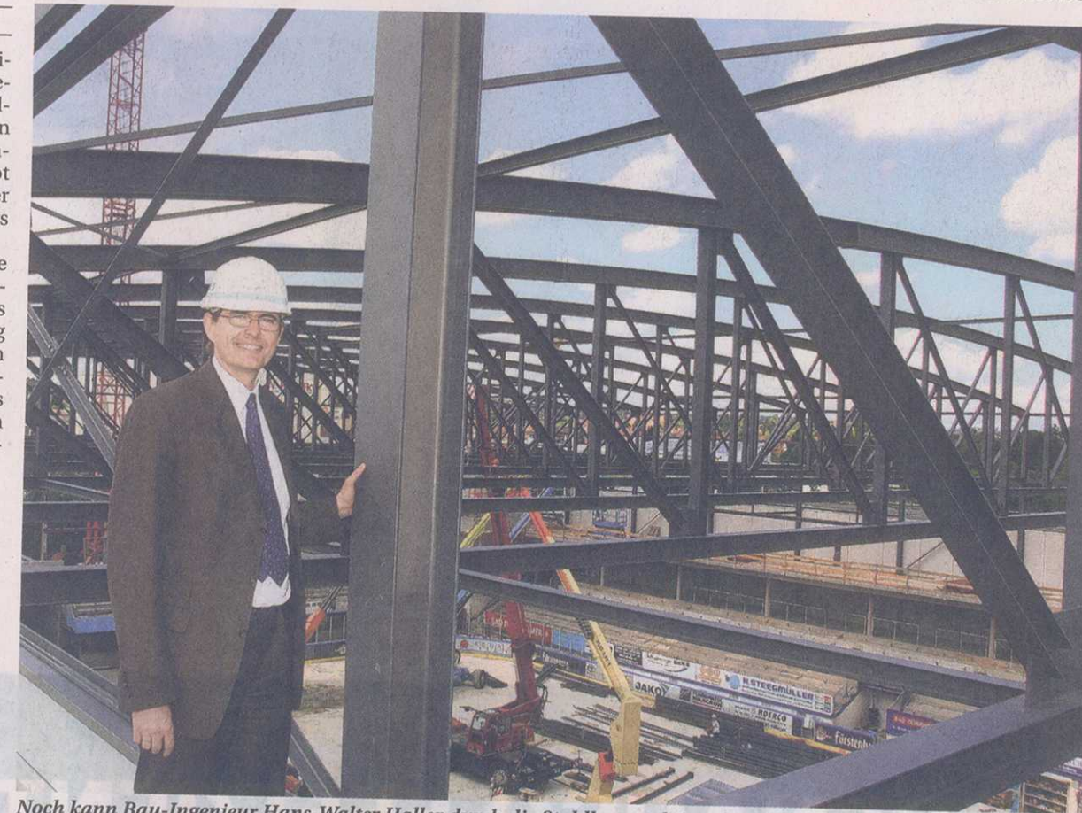
Noch kann Bau-Ingenieur Hans-Walter Haller durch die Stahlkonstruktion den blauen Himmel sehen. Bald aber werden die Träger unter dem neuen Dach der Eishalle verschwinden. Bild: Schönsmuth
